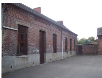
Les anciennes écoles qui accueillent les premières primaires
